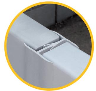
Profilé en H avec ailettes pour absorber les dilatations des panneaux.
